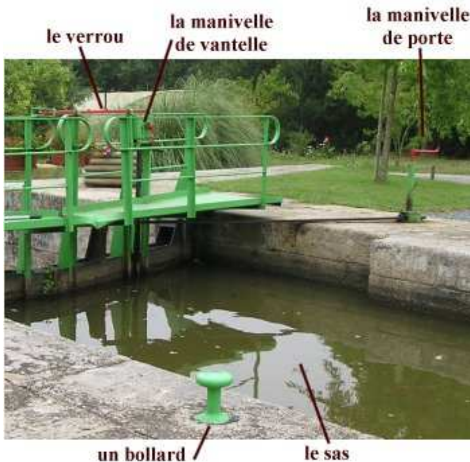
Ici, l'écluse de la Remaudais
